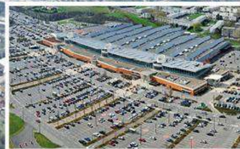
1 Parc d'activités industrielles : terminal de conteneurs d'Athus (Belgique).
