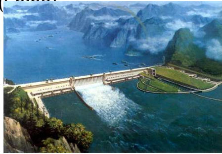
2) Barrage des Trois-Gorges sur le Yangzi Jiang (Chine)
