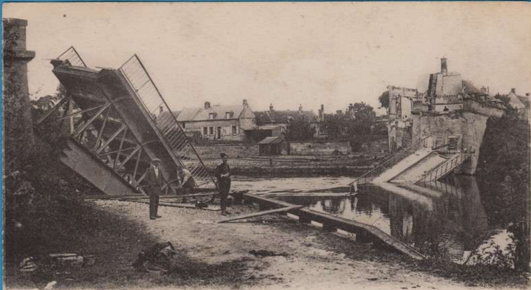
62 GUERRE 1914-1915. — Choisy-au-Bac. — Pont détruit par le Génie français. Choisy-au-Bac. — Destroyed Bridge. — L.L.
