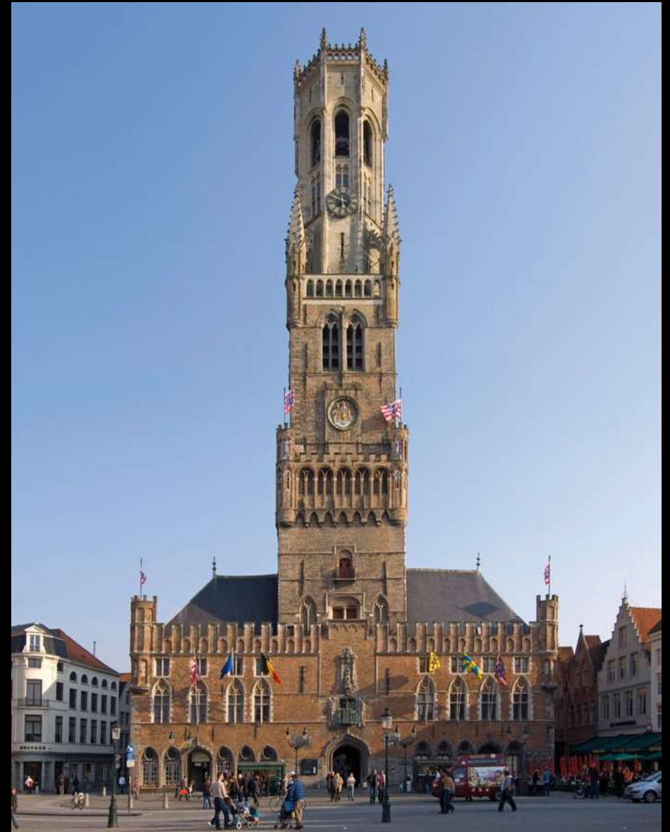
Belfroi et Halle aux laines et aux draps de Bruges.
